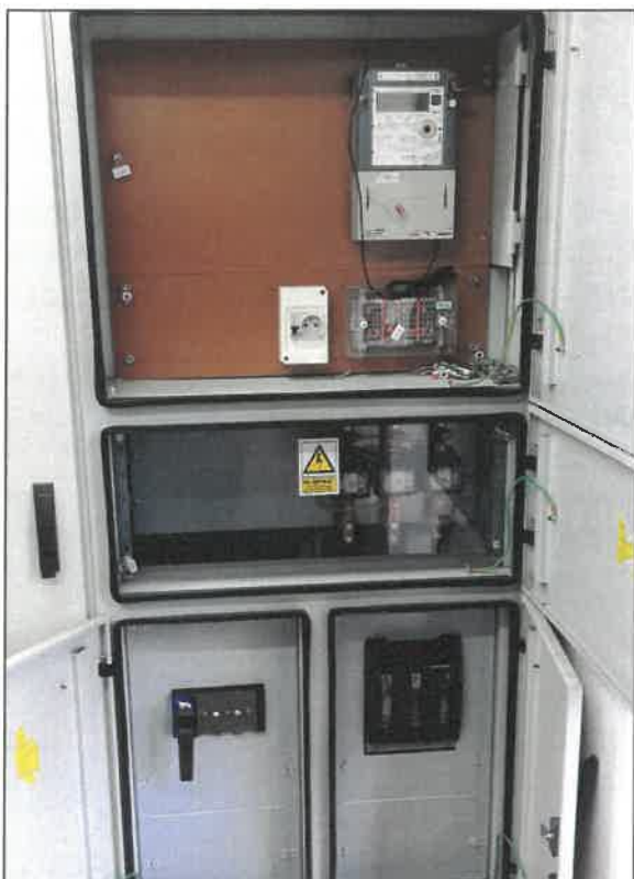
Fotografia 1. Szafa złączowo-pomiarowa energii elektrycznej na terenie oczyszczalni ścieków "Wschód" - stan aktualny.
